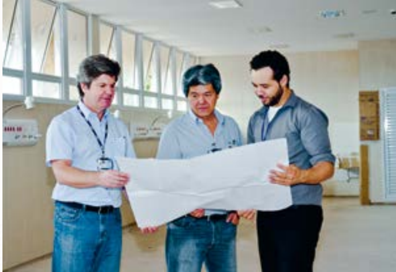
Construção da UTI Pós-cirúrgica
