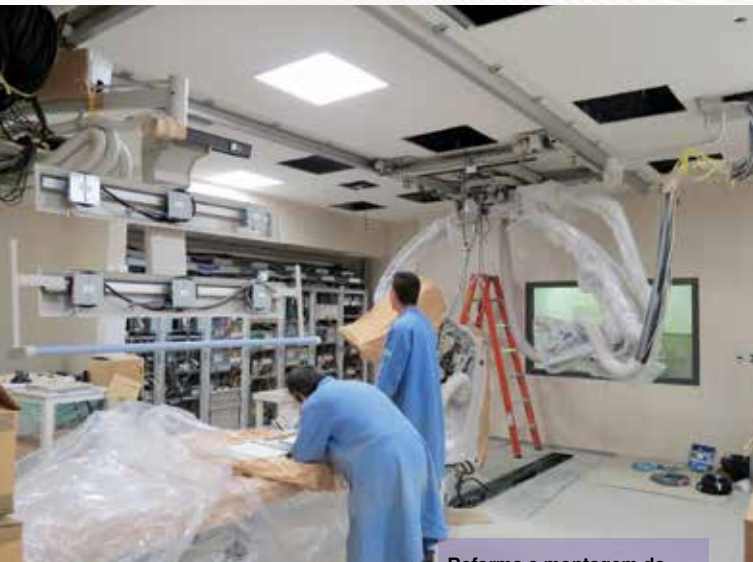
Reforma e montagem da sala do angiógrafo biplano
